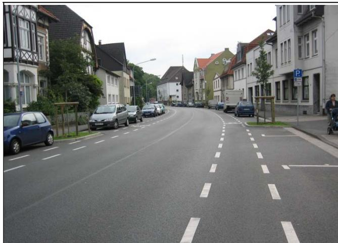
Abb. 10: Schutzstreifen mit Sicherheitstrennstreifen zu parkenden Kfz (Lemgo)
