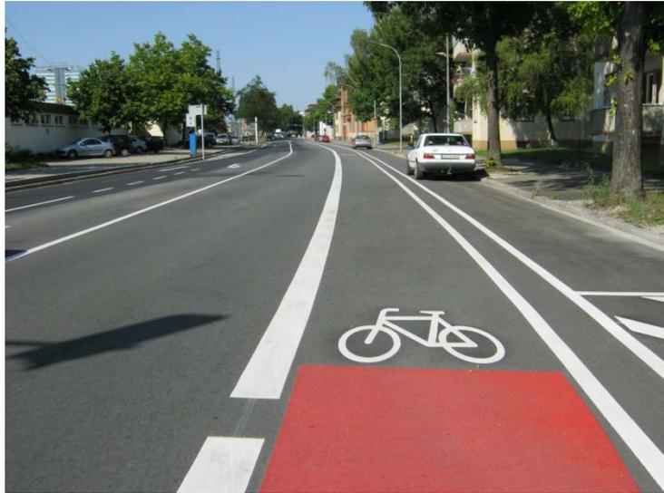
Abb. 7: Radfahrstreifen mit Sicherheitstrennstreifen zu parkenden Kfz (Singen)
