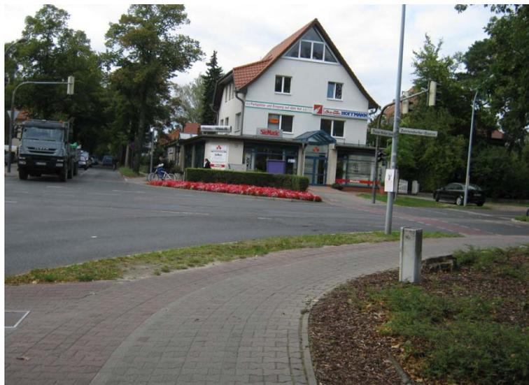
Abb. 40: Weit abgesetzte Radverkehrsfurten am Knoten Thomas-Müntzer-Damm/Zehlendorfer Damm. Empfehlung: direkte Furten ohne Absetzung.
