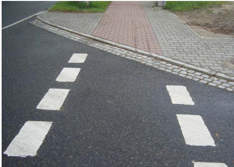
Abb. 45: Unzureichend abgesenkter Bord im Zuge eines Radweges (Stahnsdorfer Damm)
